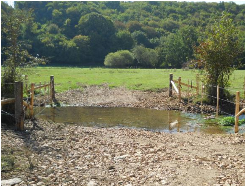
Photo 16: Exemple de passage à gué aménagé
