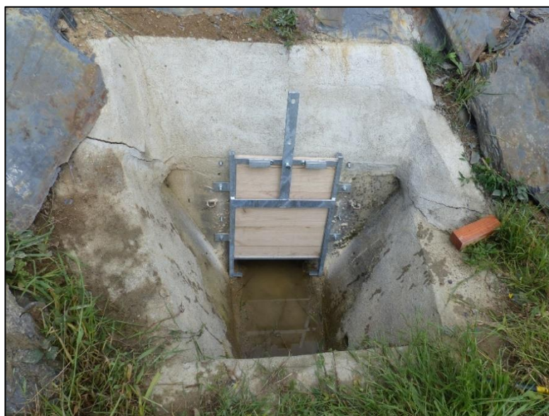
Photo 18: Ouvrage de temporisation mis en place à Congrier en 2019– Source : Syndicat du Bassin de l'Oudon
